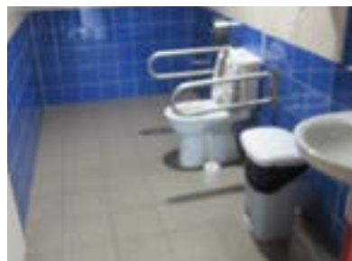
Aseo reservado con espacio de giro y transferencia adecuados.
