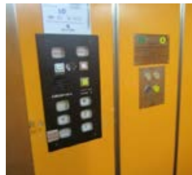
Cabina de ascensor. Pulsadores altos.
