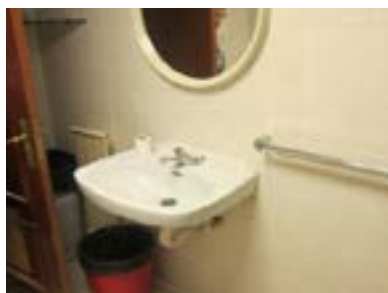
Lavabo sin fondo adecuado, grifo inaccesible y espejo altura elevada.
