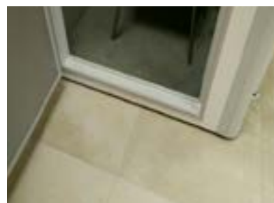
Cabina de audiometrías inaccesible.
