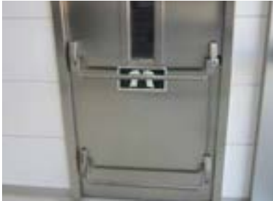
Puerta de salida de emergencias con mecanismo de apertura adecuado.
