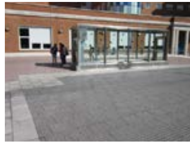
Acceso a entrada principal. Pavimento heterogéneo.
