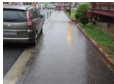
Acera sin rebaje para acceder a la misma.
