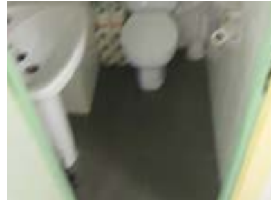
Aseo tipo. Radiología. Inaccesible.
