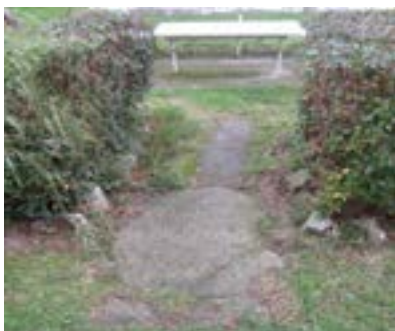
Acceso a zona de estar en jardín. Itinerario con desperfectos.
