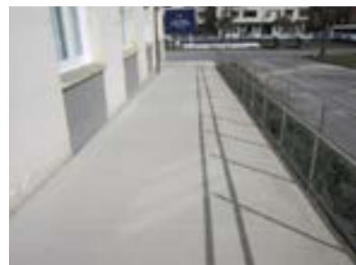
Rampa de acceso a la entrada principal.
