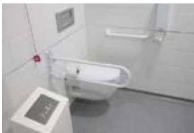
Zona de transferencia ocupada en aseo adaptado. Cordón de alarma corto.
