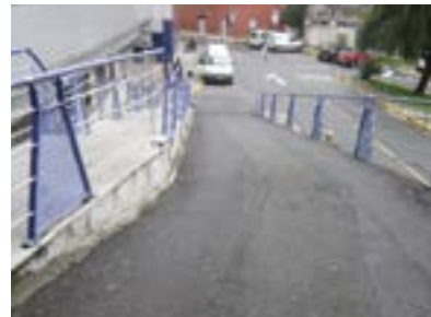
Acceso a consultas externas. Escaleras y rampa para vehículos con pendiente excesiva.
