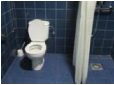
Baño adaptado, sin ningún tipo de ayudas técnicas. Edificio Arantzazu.
