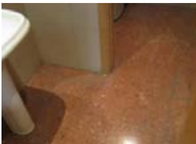
Aseo planta primera, entrada principal, no adaptado.
