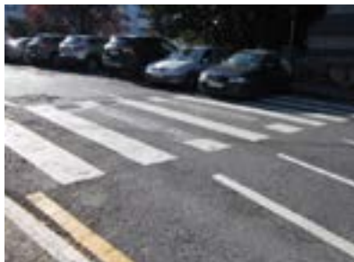
Plazas reservadas sin itinerario accesible a la clínica.
