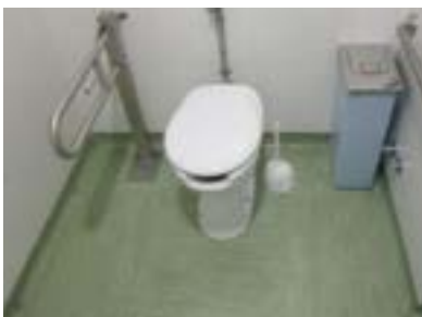
Aseo adaptado. Espacio de transferencia ocupado.
