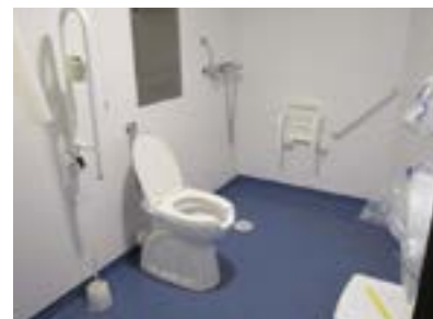
Aseo habitación adaptada. Barra asidera solo a un lado.
