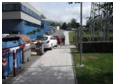
Pendiente pronunciada en el acceso a urgencias y consultas externas.
