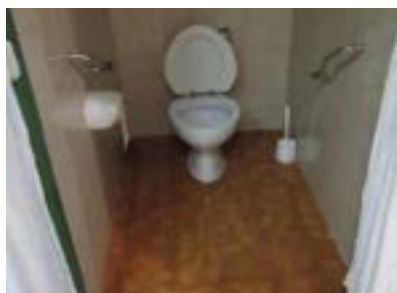
Hospital Galdakao-Usansolo. No hay espacio lateral de transferencia.
