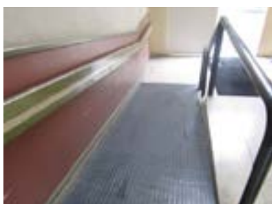
Rampa de acceso al pabellón de cartonaje.
