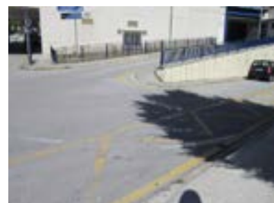
Acceso a urgencias sin vado peatonal ni acera adecuada.
