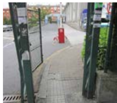
Puerta de acceso al recinto hospitalario con ancho de paso de 80 cm.
