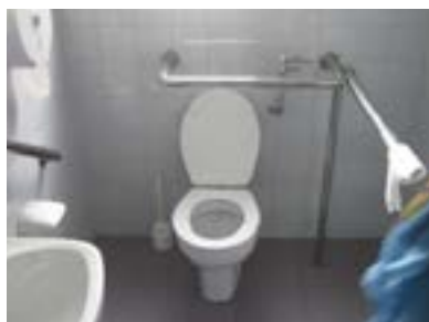
Aseo reservado en urgencias. Inodoro y barras asideras inadecuadas.
