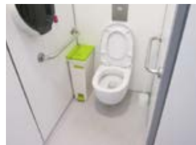
Aseo reservado. No dispone de espacio de transferencia en ninguno de los lados.
