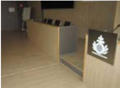
Salón de actos. Escalón para acceder al estrado.
