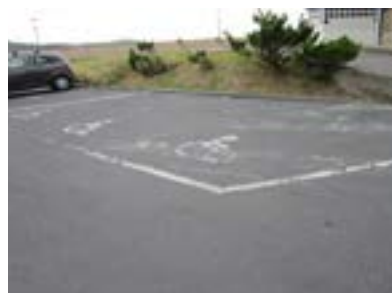
Plazas reservadas mal delimitadas y sin señalización vertical.
