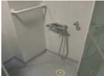
Baño de habitación. La mampara impide el giro, así como la transferencia a la ducha.
