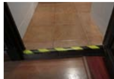
Sanatorio de Usturbil. Acceso aseo común con escalón aislado.
