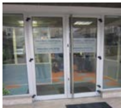
Hospital Santiago Apóstol. Puerta de acceso al hospital de día. Tirador inaccesible.
