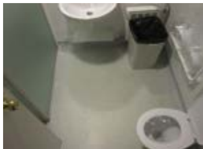
Baño de habitación. La mampara impide el giro a las personas usuarias de silla de ruedas. La puerta abre hacia el interior.
