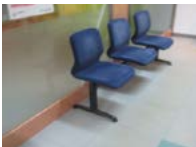
Sala de espera. Espacio adecuado para personas usuarias de silla de ruedas, aunque no señalizado.
