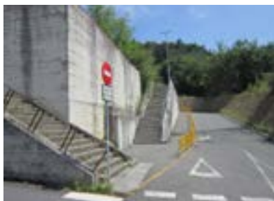
AG2. Escaleras de acceso a aparcamiento, sin rampa alternativa.
