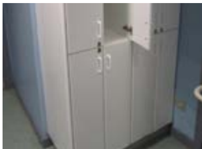
Hospital Victoria Eugenia. Armarios inaccesibles.
