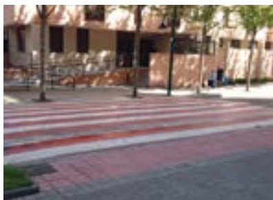
Paso de peatones con obstáculos en itinerario peatonal.
