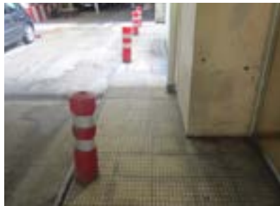
Hospital Galdakao-Usansolo. Acceso a velatorio. Aceras estrechas, con obstáculos. No hay señalización en el suelo.
