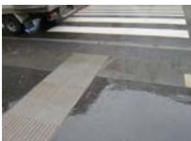
Calle Beato Tomás de Zumarraga. Franjas señalizadoras sin contraste cromático.
