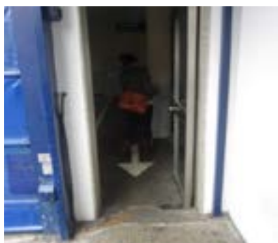
Hospital Txagorritxu. Puerta de acceso a urgencias estrecha.
