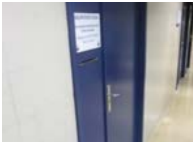
Hospital Galdakao-Usansolo. Buzón alto. La información no está en braille ni altorrelieve.
