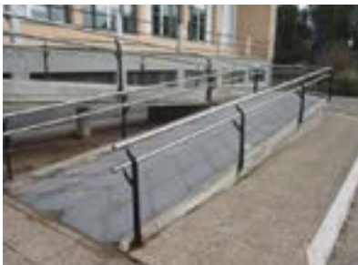
Rampa de acceso a la entrada principal.
