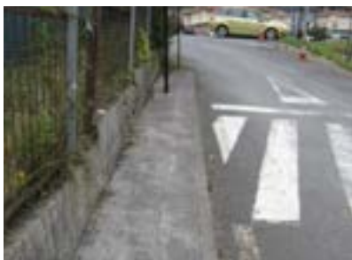
Acceso exterior al aparcamiento, acera con ancho insuficiente.
