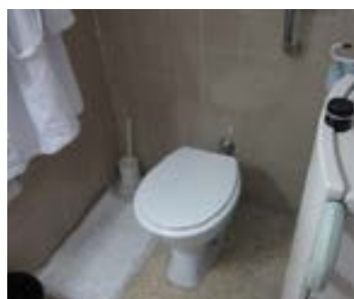
Hospital Txagorritxu. Inodoro inaccesible.
