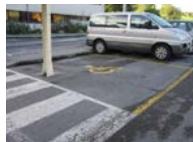
Plaza reservada sin señalización vertical.
