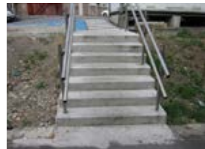
Hospital de Zumarraga. Escalones.
