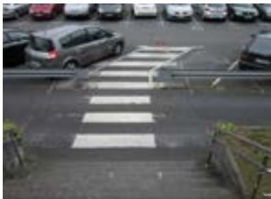
Hospital San Eloy. Escaleras en itinerario.
