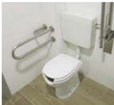
Baño en habitación adaptada. Inodoro adaptado adecuadamente.
