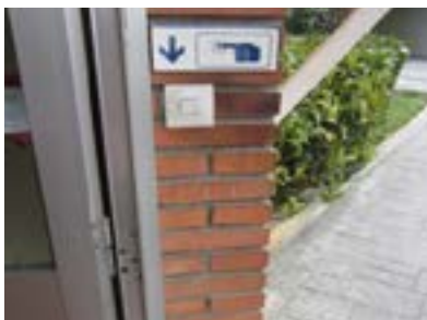
Timbre de llamada urgencias, instalado a altura elevada y voladizo sin proyección horizontal en itinerario peatonal.
