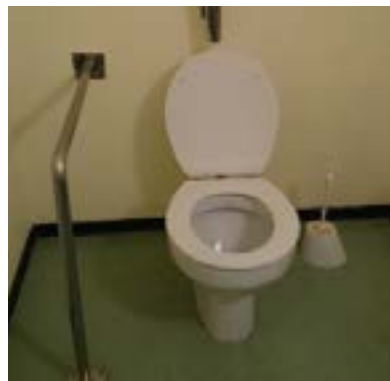
Aseo consulta de radiología. Barra inadecuada y falta de otra barra.
