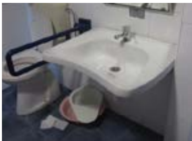
Baño habitaciones adaptadas. Sin espacio de transferencia, barra asidera solo a un lado...
