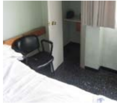
Hospital Santiago Apóstol. Armario inaccesible por puerta estrecha.
