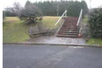
Escaleras de acceso al edificio rojo.
