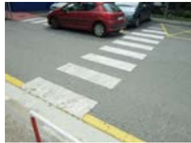
Hospital Universitario Donostia. Paso peatonal con escalón. Paso accesible con coche aparcado frente a él.
