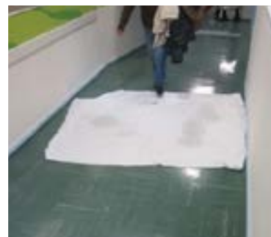
Hospital de Cruces. Pasillo del edificio central.
