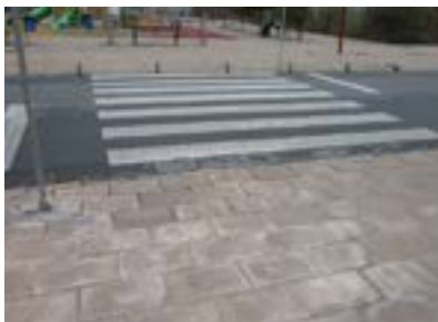
Bolardos de dimensiones reducidas en acceso desde la calle Txeta.
