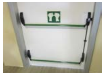
Hospital de Cuidados San Onofre. Barra a doble altura.
