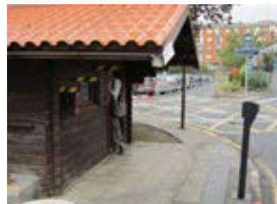
Voladizo en caseta sin proyección horizontal.
