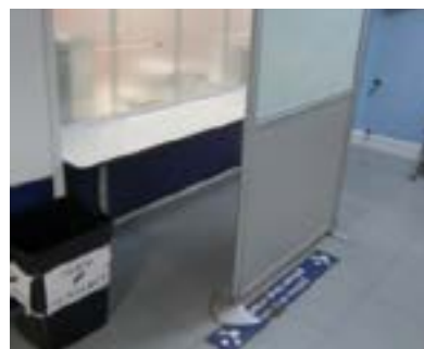
Hospital San Eloy. Mostrador inaccesible por mampara.
