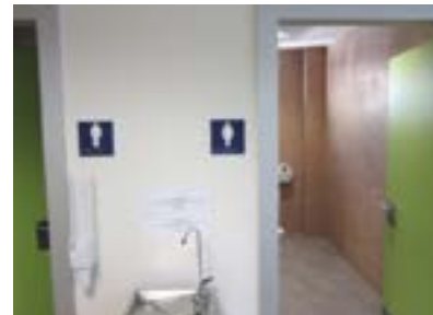
Aseo común adaptada zona hospitalización. Puerta apertura hacia interior del aseo, en aseo recién reformado.
