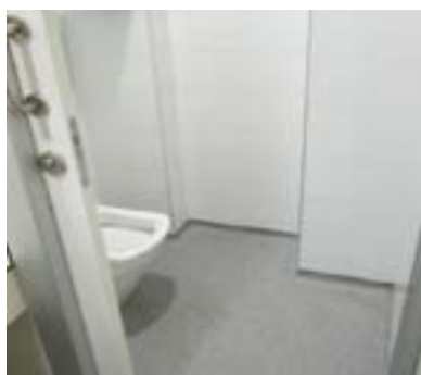
Aseo un solo tipo en hospitalización, sin adaptar. Edificio Amara.
