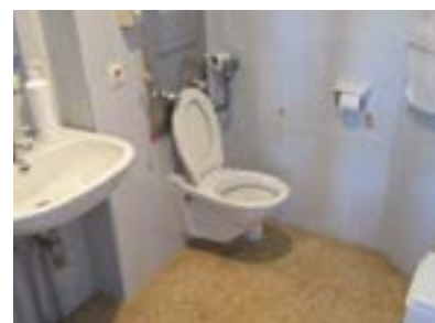
Aseo tipo, habitaciones sin reformar.
