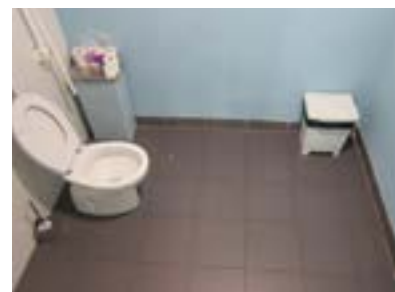
Aseo reservado, planta tercera. Barras asideras solo a un lado e inodoro bajo.
