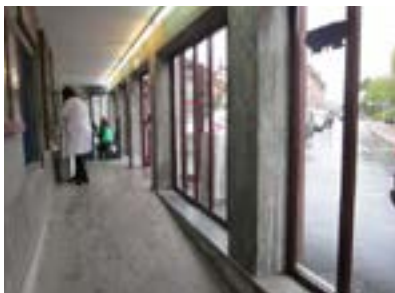
Acceso a la cafetería.
