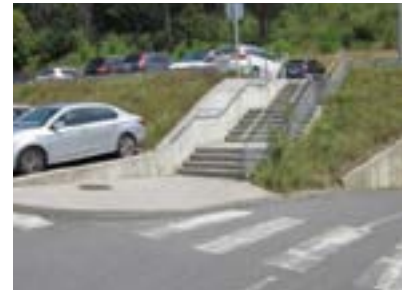
Hospital Galdakao-Usansolo. Escaleras sin rampa alternativa.
