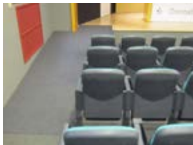
Salón de actos edificio Arantzazu. Rampa pendiente pronunciada sin pasamanos.
