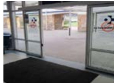
Hospital de Gorniz. Entrada. Faltan franjas guías y contraste en las puertas.
