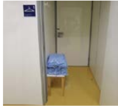
Vestuario tipo, consulta de radiología. Dimensiones reducidas, inaccesible.
