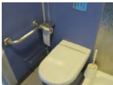
Aseo tipo en habitación del pabellón Revilla.
