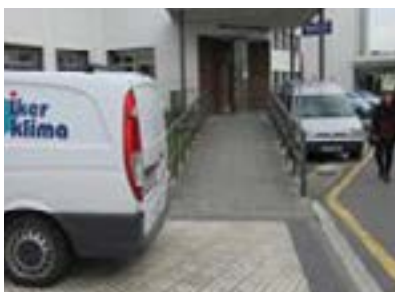
Entrada de consultas externas Gipuzkoa. Rampa sin pasamanos a doble altura, puerta de entrada sin ancho libre de paso, adecuado y pesada para su apertura.
