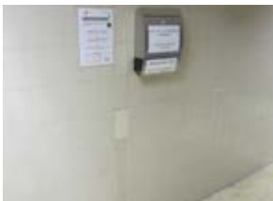
Hospital Galdakao-Usansolo. Buzón alto. Puede causar golpes, ya que no se proyecta hasta el suelo.
