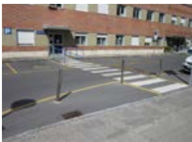
Plazas reservadas. Zona consultas externas-cafetería. Falta señalización vertical.
