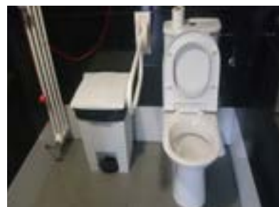
Aseo adaptado sin barra asidera a un lado, espacio de transferencia ocupado y alarma enrollada.
