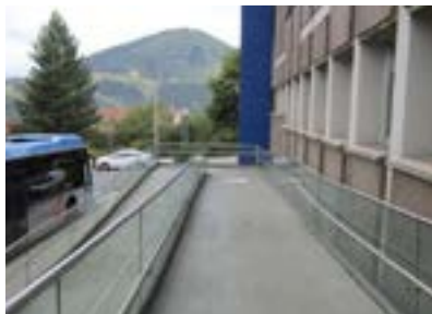
Rampa de acceso a la entrada principal. Sería conveniente que esta rampa estuviera cubierta.
