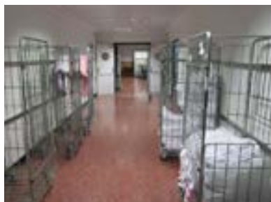
Obstáculos en acceso a farmacia. Falta de señalización direccional.
