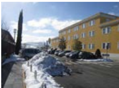
Zona de aparcamientos. No se distingue en dónde se encuentra el aparcamiento reservado.
