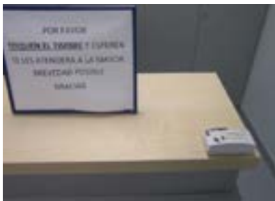
Timbre en superficie horizontal inaccesible.
