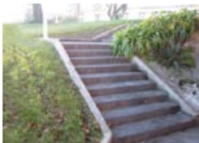
Escalares de acceso a salas de reuniones familiares. No tienen barandillas ni rampa alternativa.
