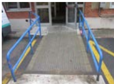
Hospital de Cruces. Entrada al edificio "W". No hay señalización en el acceso a la rampa.
