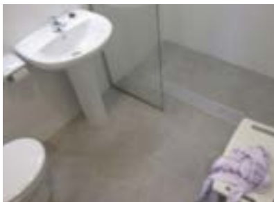
Baño tipo reformado de habitación.
