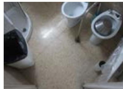
Aseo tipo en habitación de hospitalización. Barra fija en el inodoro, sin paso de transferencia. Ducha inaccesible.
