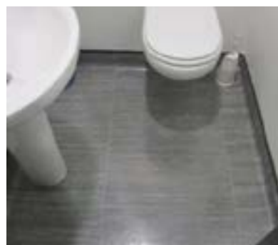
Aseo tipo. Radiología. Inaccesible.
