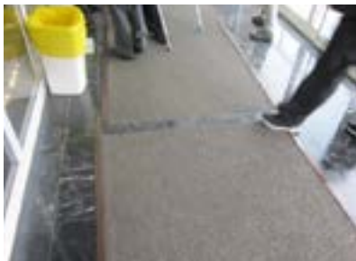
Entrada de consultas externas. Felpudo anclado mediante perfiles creando cejas.
