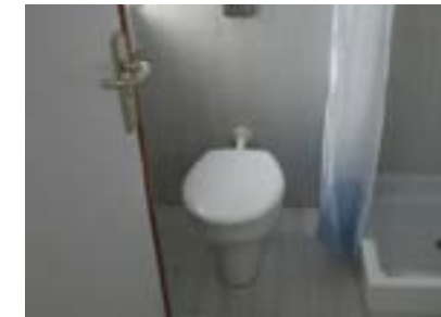
Baño tipo, habitación, sin ninguna adaptación. Edificio psiquiatría unidad infantil.
