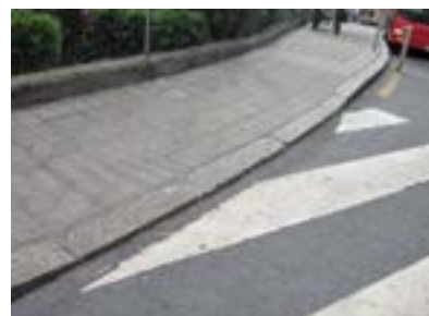
Paso de peatones con escalón en vado.
