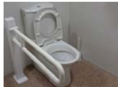
Aseo adaptado zona urgencias. Barra asidera solo a un lado. Y sin espacio de transferencia.
