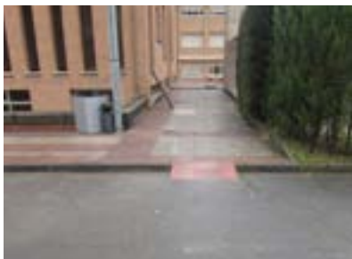
Rampa características inadecuadas.
