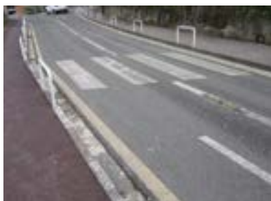
Aceras de acceso desde la parada de autobús a la entrada principal, con ancho libre inadecuado y paso peatonal sin vados.
