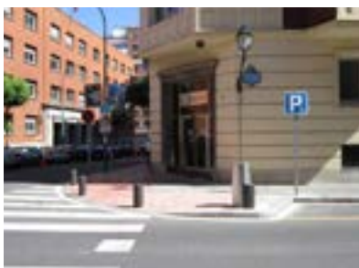
Entrada principal. Escalón en acceso.
