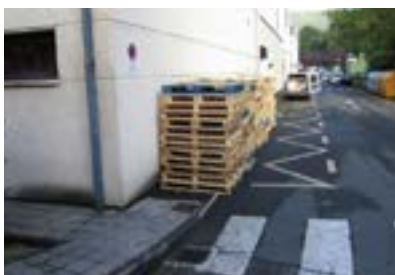
Acera con ancho insuficiente, obstáculos en itinerario peatonal y paso de peatones sin vado.
