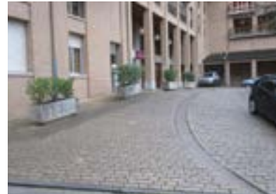
Acceso en pendiente a la entrada principal. Sin pasamanos y pavimento resbaladizo. Falta plaza reservada en esta zona.
