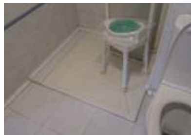
Baño de habitación en p 2. Plato de ducha con pequeño escalón, sin espacio de giro, sin barandillas pasamanos...
