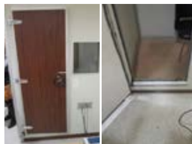
Hospital San Juan de Dios. Escalón en el acceso a la cabina.
