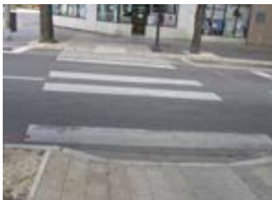
Franjas señaladoras sin contraste cromático y paso mal realizado.
