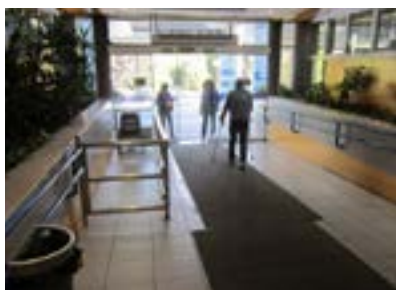
Rampa de acceso con pendiente elevada, pavimento resbaladizo, felpudos no fijos y obstáculos en itinerario. Los pasamanos quedan fuera de la zona de la alfombra y no ayudan en la subida o bajada.
