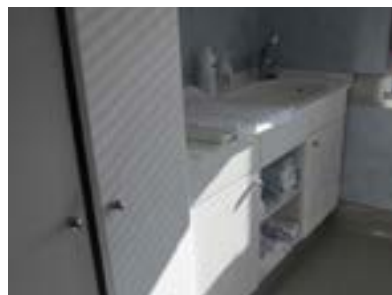
Cambiador de bebés inaccesible.
