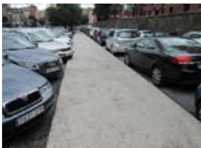
Itinerario peatonal sin franja guía de señalización, ni bordillo de orientación para personas con discapacidad visual.
