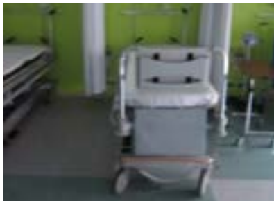
Espacio de transferencia insuficiente en box de cirugía ambulatoria.
