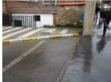
Hospital Vithas San José. Estrechamiento de acera. Escalón aislado, inaccesible.
