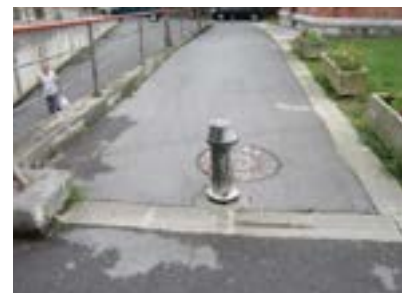
Hospital de Basurto Bolardo en itinerario sin contraste adecuado. Puede causar tropiezos.
