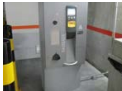
Parquímetro edificio aparcamiento. No accesible.
