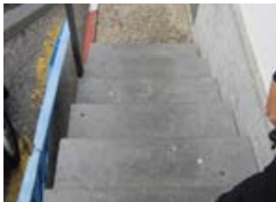
Hospital Universitario Donostia. Edificio Gipuzkoa. Acceso exterior. Inaccesible.
