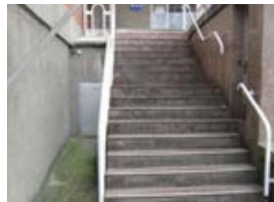
Cafetería. Escaleras de acceso desde el exterior.
