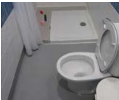
Baño en habitación tipo, edificio Rojo.
