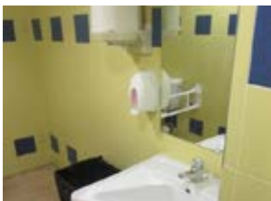
Accesorios de lavabo instalados a altura elevada.
