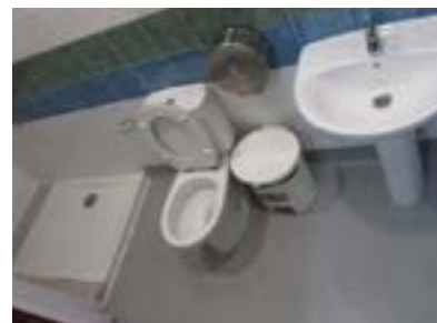
Hospital Psiquiátrico de Zaldibar. Sin espacio de transferencia.
