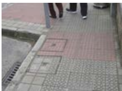
Obstáculos en calle Bidebarrieta. Acera estrecha.
