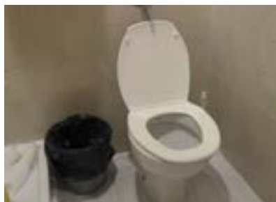
Aseo consulta radiología inaccesible.
