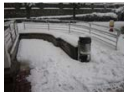
Hospital Psiquiátrico de Zaldibar. Pasamanos en un lado. Sin señalización.
