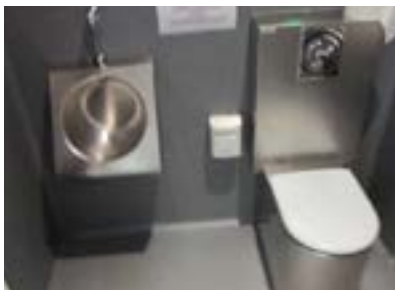
Aseo especial, área tratamientos, sin adaptar.
