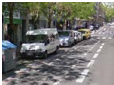
Aparcamiento en la calle Olaguibel sin plaza reservada.
