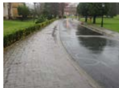
Acera de acceso a los edificios U.L.E, 1, 2 y 3, sin rebaje.
