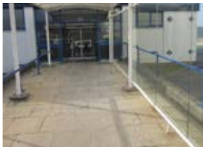
Acceso a piscina sin pasamanos a ambos lados y a doble altura.
