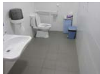
Aseo reservado en el sótano. Barra asidera solo a un lado.
