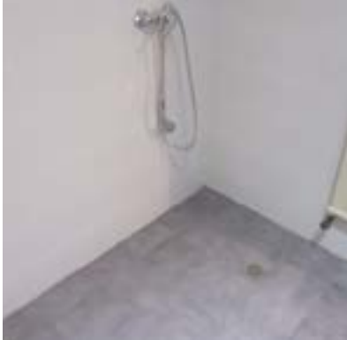
Baño tipo reformado en habitación de hospitalización.
