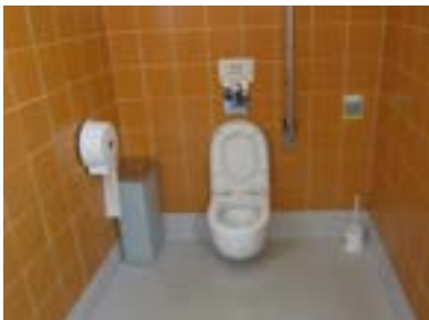
Aseo reservado. Espacio de transferencia ocupado.
