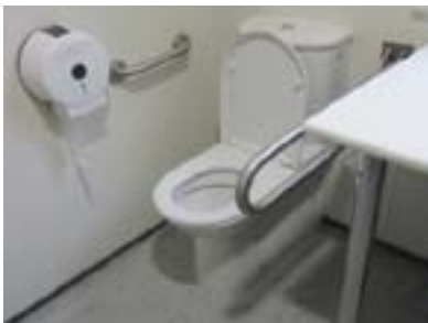
Aseo adaptado. Espacio de transferencia ocupado con mesa.
