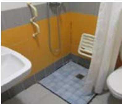
Baño en habitación tipo, edificio 3.
