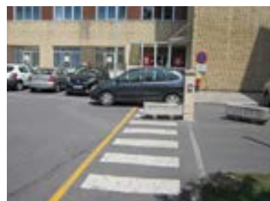
Paso peatonal con obstáculos en itinerario.
