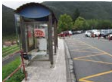
Hospital de Mendaro. Marquesina inaccesible.
