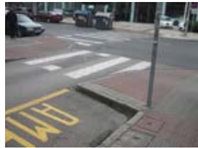
Franjas señalizadoras instaladas inadecuadamente.
