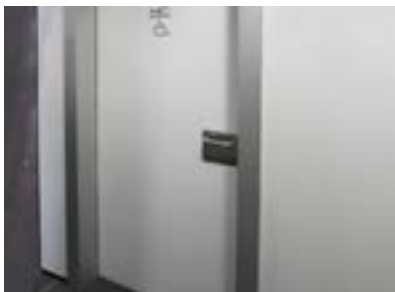
Puerta apertura hacia dentro en aseo reservado y cambiador de bebés.
