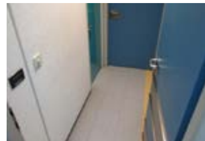
Hospital de Basurto. Edificio Revilla. Acceso a aseo común. Pasillos estrechos.
