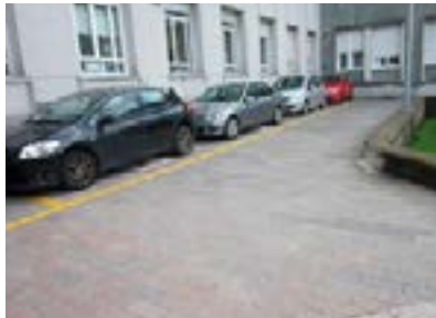
Plazas reservadas frente al edificio Arantzazu. Dimensiones y señalización inapropiada.
