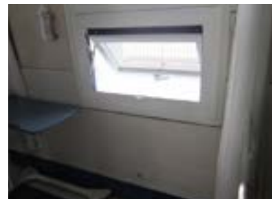
Sistema de apertura a altura accesible en ventanas de habitación.
