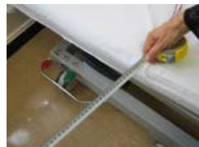
Espacio insuficiente de transferencia en consulta yesos. Edificio Gipuzkoa.
