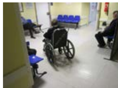
Sala de espera sin espacio para las personas usuarias de silla de ruedas.
