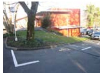
Plaza reservada en pendiente sin señalización vertical y sin dimensiones.
