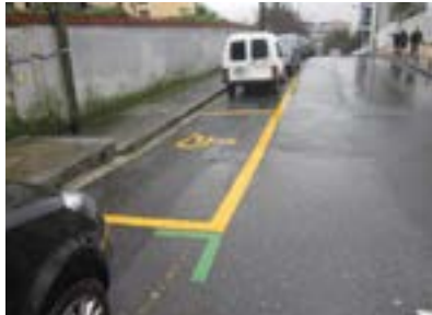
Plaza reservada en la entrada principal. No dispone de dimensiones adecuadas ni señalización vertical.
