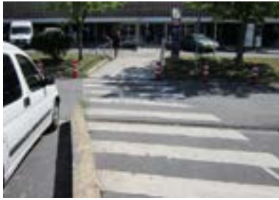
Hospital Galdakao-Usansolo. Acceso a consultas externas. Isleta con escalón.
