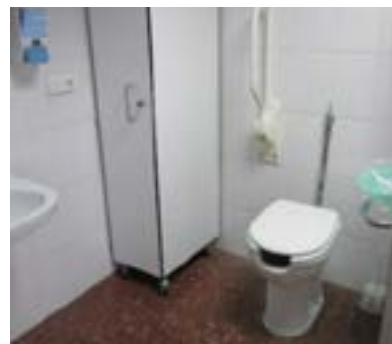
Hospital de Zumarraga. Habitación adaptada. Armario que impide el traslado lateral.
