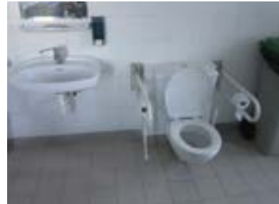
Baño asistido. Espacio de transferencia reducido, inodoro bajo...
