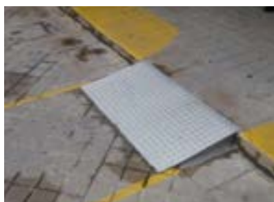
Hospital Santiago Apóstol. Acceso al hospital de día. Rampa corta.
