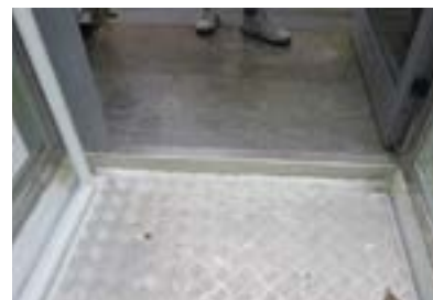
Diferencia de cotas de la plataforma elevadora.
