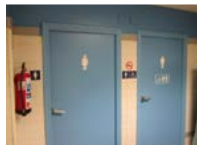
Puerta apertura hacia dentro en aseo adaptado.
