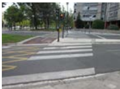
Hospital Txagorritxu. Isleta con ancho adecuado de paso.
