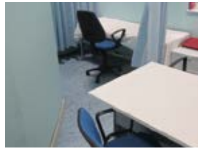
Acceso a la camilla por paso reducido. Consulta de digestivo.
