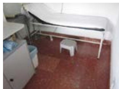
Consulta, zona de camilla espacio reducido de giro y transferencia. Camilla sin altura variable.
