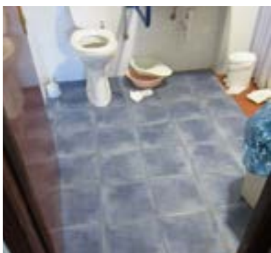
Baño habitación adaptada. Puerta apertura hacia dentro.
