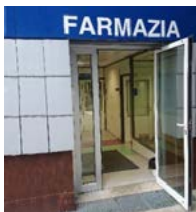
Farmacia del Hospital Universitario Donostia. Puerta sin bandas señalizadoras.
