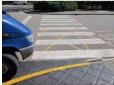
Paso de cebra con escalón y sin rebaje.
