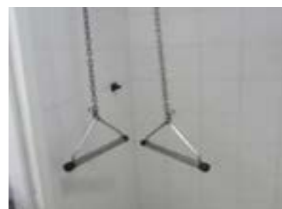
Hospital de Basurto. Edificio Arrupe. Asidero.
