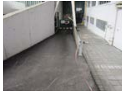
Rampa de acceso al tanatorio.
