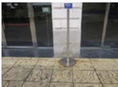
Señalización para personas con discapacidad visual. Sin franja guía de dirección.
