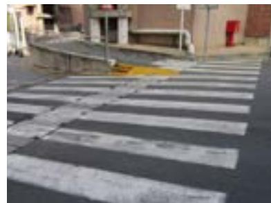
Cafetería-consultas externas-oncología, pasos de peatones mal resueltos.
