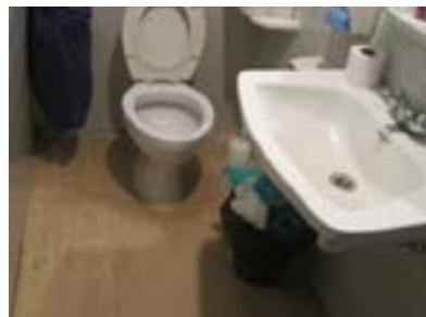
Aseo-vestuario consulta de Ginecología. Edificio materno-infantil.
