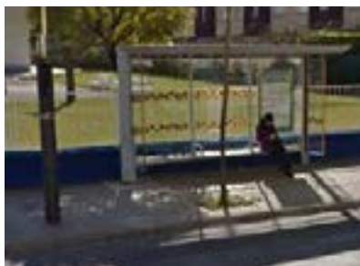
Marquesina en itinerario peatonal. No dispone de proyección horizontal. Además, se localizan árboles sin alcorque.
