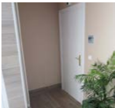
Acceso a aseo reservado. No permite realizar giro antes de la puerta. Acceso con dificultad.
