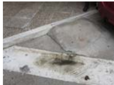
Rampa de acceso a la acera del edificio de las monjas.
