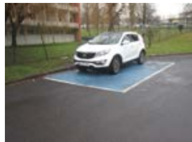
Plaza reservada en aparcamiento general. No dispone de señalización vertical.
