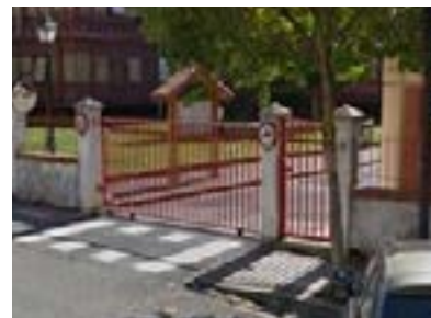
Puerta de acceso al recinto. Escalón en acceso peatonal.
