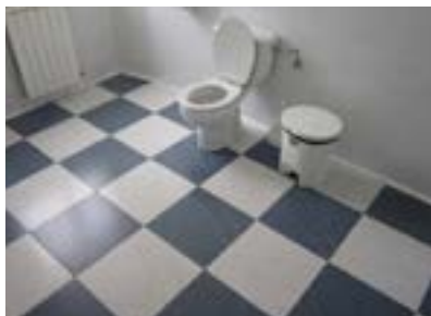
La superficie del aseo es adecuada, el inodoro está situado a baja altura, y sin ninguna ayuda técnica.
