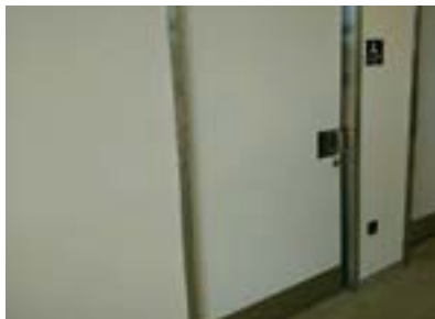
Puerta de paso a aseo reservado.
