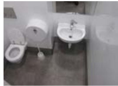
Aseo pediátrico. Espacio reducido para asistencia del bebé por familiar usuario de silla de ruedas.
