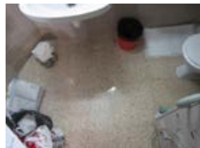
Aseo en consulta de mamografías. Inaccesible.
