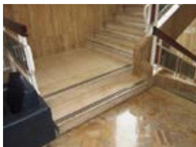
Clínica Virgen Blanca. Escaleras principales. Escalón con bocel.
