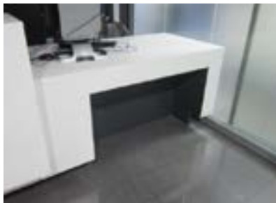
Mostrador accesible con ciertas deficiencias.
