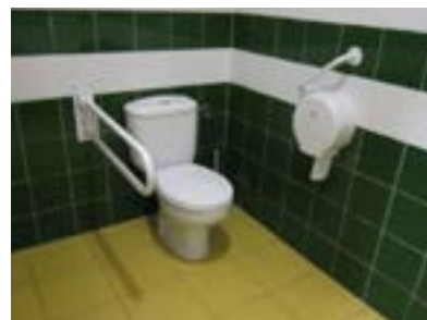
Aseo adaptado rehabilitación con inodoro bajo y puerta de apertura hacia dentro del aseo.
