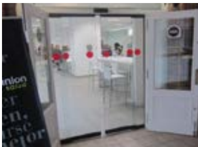
Cafetería del Hospital Galdakao-Usansolo. Puertas estrechas sin bandas señalizadoras.
