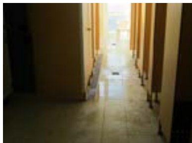
Acceso a vestuario accesible en piscina.
