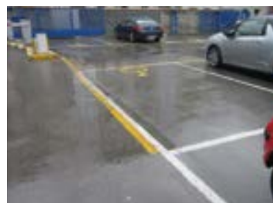
Aparcamiento. Plazas reservadas sin señalización vertical.
