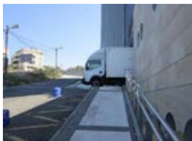
Hospital Ricardo Bermingham. Exterior. Pendiente excesiva.
