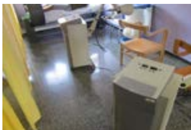
Hospital de Basurto. Pabellón Ampuero. Equipamiento inaccesible.
