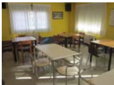
Comedor para uso exclusivo de pacientes. Mobiliario distribuido inadecuadamente.
