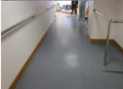
Donostiako Unibertsitate ospitalea. Amara eraikina. Lehenengo solairua. Malda gehiegi duen arrapatatik sartu behar da.
