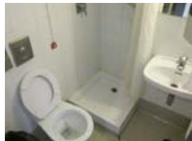
Dutxaontzi iristezina duen komun mota, logela irisgarririk ez duten unitateetan.
