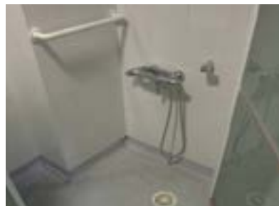
Logelako komuna. Manparak bira egitea galarazten du, baita dutxara transferentzia egitea ere.
