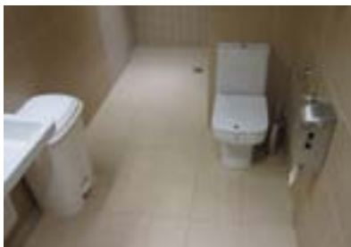
Komuna. Erditzeko gela. Gurpildun aulkien erabiltzaileek ezin dezakete bira egin eta ez dauka laguntza teknikorik.
