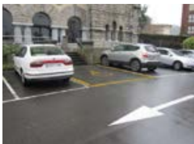
Ezinduen aparkalekua errehabilitazio-gunean. Ez dauka seinalaztapen bertikalik. Aparkalekutik, ez dago errehabilitaziorako sarbiderik. Eskaileretara iristea oztopatzen du.
