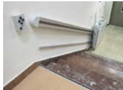
Eskailerak saihesteko plataforma zeharra.
