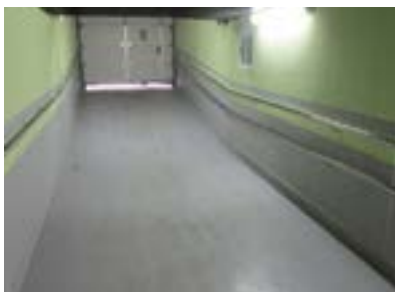
Kanpoaldetik, sotora iristeko arrapala. Gehiegizko malda.
