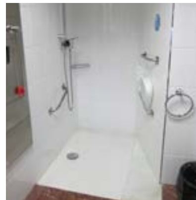
Egokitutako logelako komunak. Dutzak neurri txikiak, transferentzia egiteko eserlekurik gabe, eta alarma altuegi.
