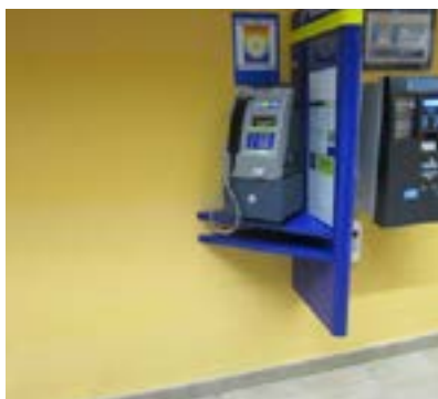
Proiektzio horizontalik gabeko hegalk sarrera nagusian, estropezuak eragin diezazkieke horrek ikuspen-ezintasuna duten pertsonen.
