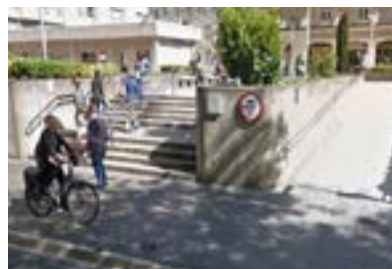
Gehiegizko aldapa dauka sarrera nagusirainoko arrapalak.
