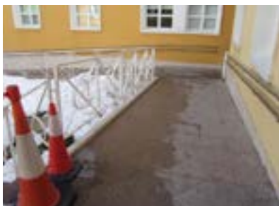
Gehiegizko aldapa dauka sarrera nagusirainoko arrapalak.
