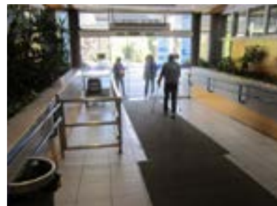
Sarrerako arrapalak malda handia, zoladura irristakorra, finkatu gabeko lanpasak eta oztopoak bidean. Eskubandak ez daude alfonbraren zonaldean, eta ez dute igotzen edo jaisten laguntzen.
