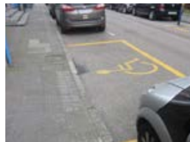
Ezinduei gordetako aparkalekua. Erdigunean dago espaloirako sarbidea, aparkatutako ibilgailuarekin bat eginez.
