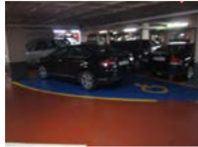
Ezinduei gordetako aparkalekua. Lurrazpiko aparkalekua. Seinaleztapen bertikala falta da.
