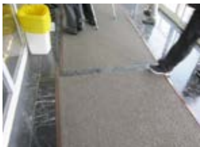
Kanpo-konsulten sarrera. Profilen bidez iltzatutako lanpasa, irtenguneak sortuz.
