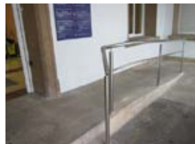
Amara eraikineran iristeko arrapala. Zabalera ez da nahikoa, eta kontrastea eta eskubanda falta dira ibilbide osoan, bi alboetan.
