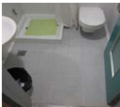
Eraikin nagusiko logeletako komuna. Dutxa iristezina, eta komun-zuloak ez dauka transferentziarako tokirik.
