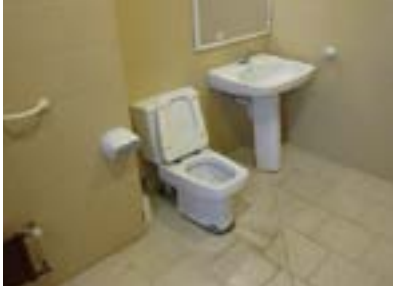
Lagundutako komuna. Ez dauka heldulekurik, ezta transferentzia egiteko toki egokirik ere.
