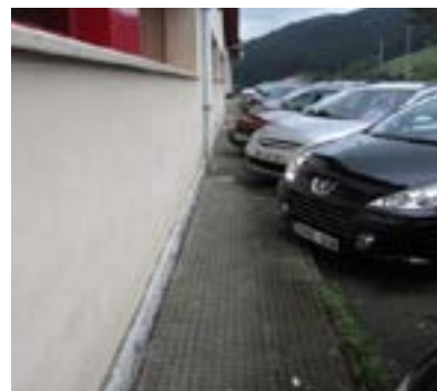
Zabalera nahikoa ez duen espaloia, eta kotxeek hartua.
