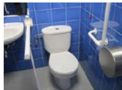
Logelako ezinduen komuna, komun-zulora transferentzia egiteko tokirik gabe. Komun-zuloa baxua da, eta alarma altuera handian jarrita dago.
