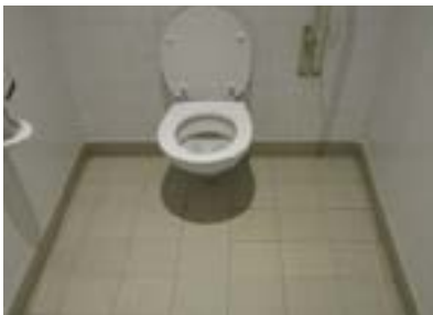
Lehenengo solairuan gordetako komuna. Albo batean ez dauka heldulekurik, eta ez dago transferentzia egiteko lekurik.
